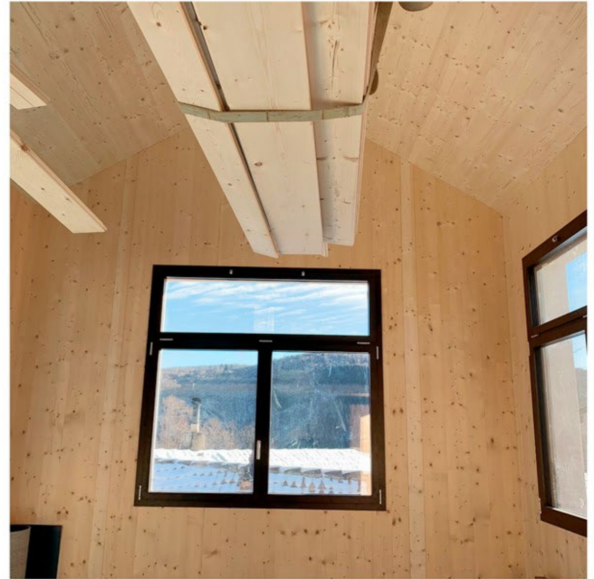
Auch im Innern Holz doppelwandig mit Isolation. Grosse Fenster mir Rundumsicht
